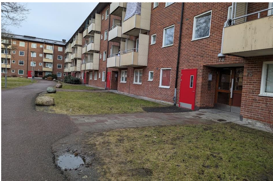
Figur 14. Innergård med nivå på färdigt golv och entréer något under anslutande mark. Bilden visar även dagvatten som inte infiltrerat (Foto: Petter Mogenfelt).
