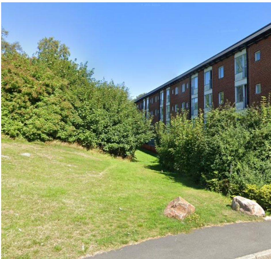
Figur 17. Slänt ner mot befintlig byggnad inom planområdet. Skyfallskartering visar på risk för höga vattennivåer mot byggnaden (Foto: Google).
