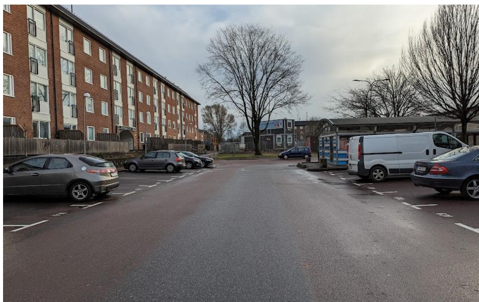
Figur 15. Parkering i den norra delen av planområdet där skyfallskartering visar på risk för (tillfälligt) höga vattennivåer (Foto: Petter Mogenfelt).
