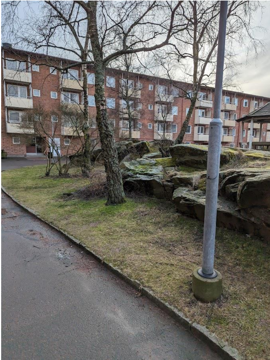
Figur 12. Innergård med stor andel berg i dagen (Foto: Petter Mogenfelt).
